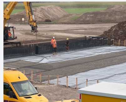
Verticale wanden, mechanisch opgebouwd met RE geogrids, geïnstalleerd om cellen te vormen.
