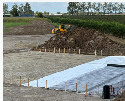
Geogrids uit de H-serie geïnstalleerd om een basis te leggen voor de daaropvolgende constructie van cellen.
